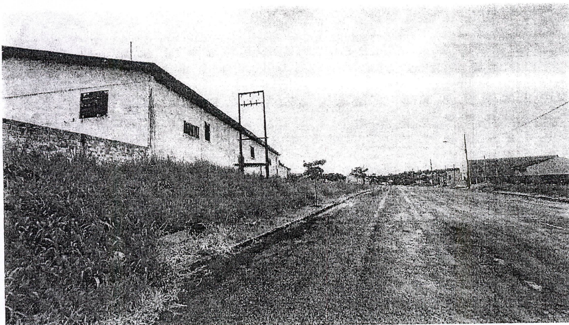
Fachada Rua Daniel Vivan (Figura 02)
